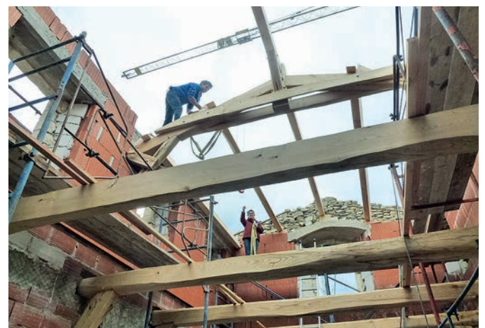
Der wunderschöne Dachstuhl aus Eichen- und Kastanienholz über der künftigen Bibliothek von St. Hippolyte.
