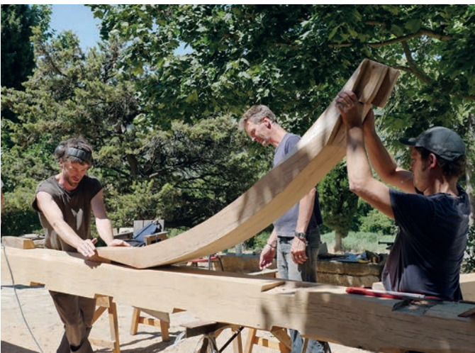
Unsere Holzbau-Künstler passen verschiedene Elemente für den Dachstuhl an.
